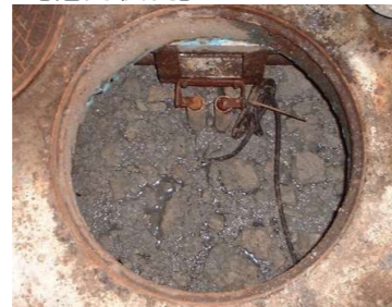
改修前(原水槽)
