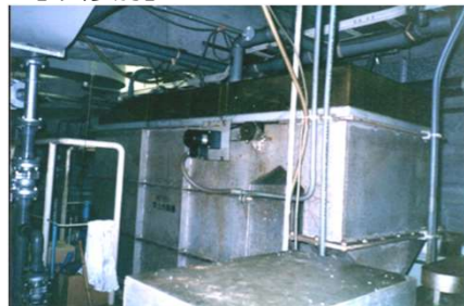
加圧浮上装置 → 改修後撤去
